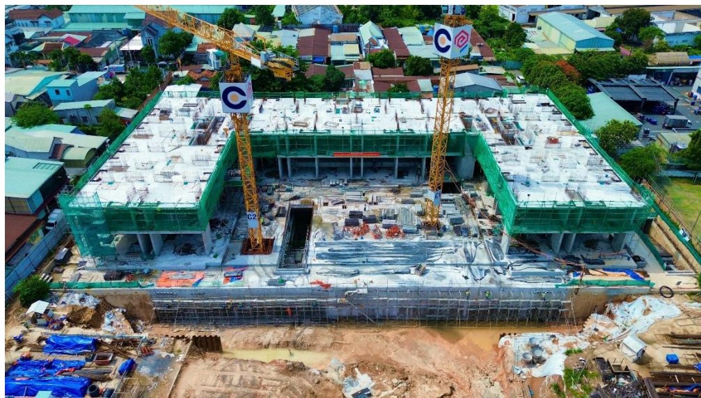
Hình 1: Tiến độ xây dựng tại Thuận An 1
