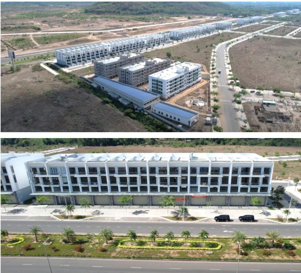
Hình 10: Các căn shophouse tại dự án khu dân cư Hữu Phước
