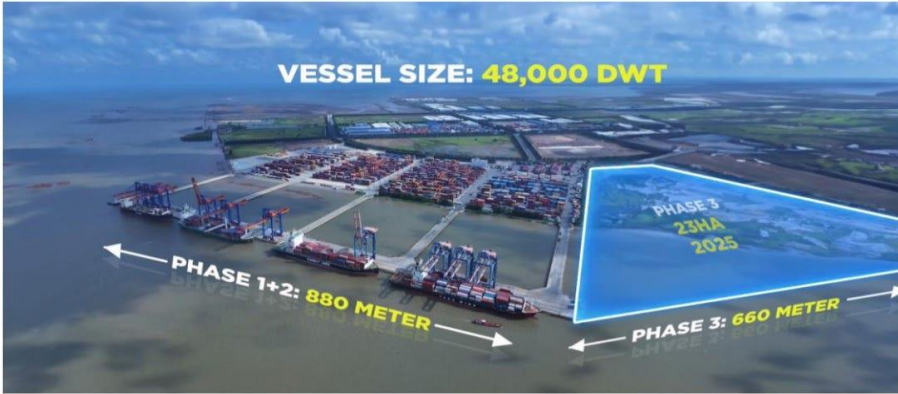
Hình 16: Thông tin dự án mở rộng cảng Nam Đình Vũ giai đoạn 3
