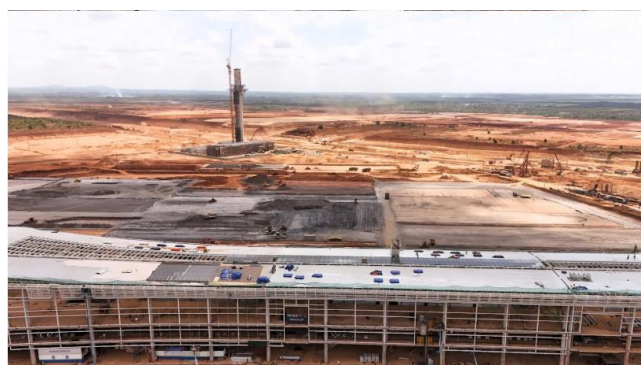
Ảnh 10. Tiến độ sân bay Long Thành tháng 03/2025
