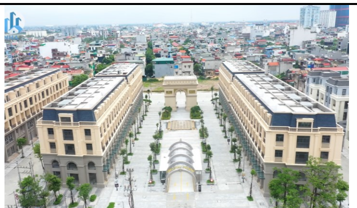
Hình 19: Tiến độ thi công The Light Square tháng 8/2024
